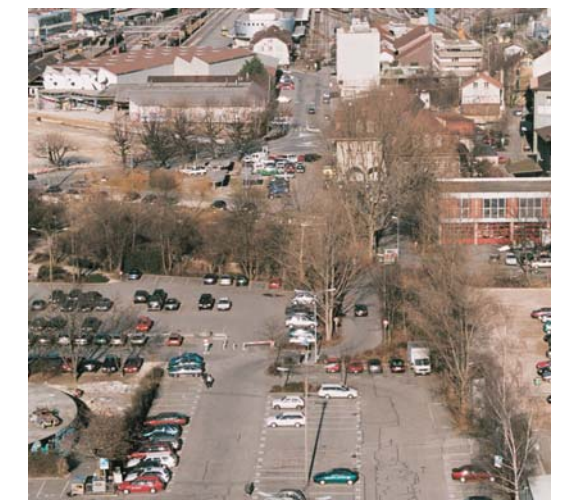
Situation vor dem Bau
