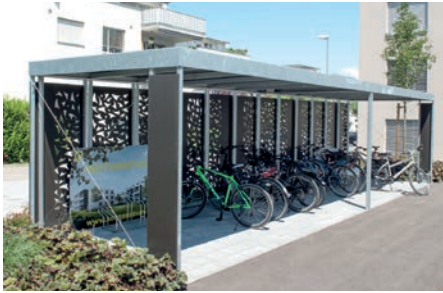
Veloparkplätze in Nebengebäuden sind besser zu erreichen und günstiger zu erstellen als in Untergeschossen.
