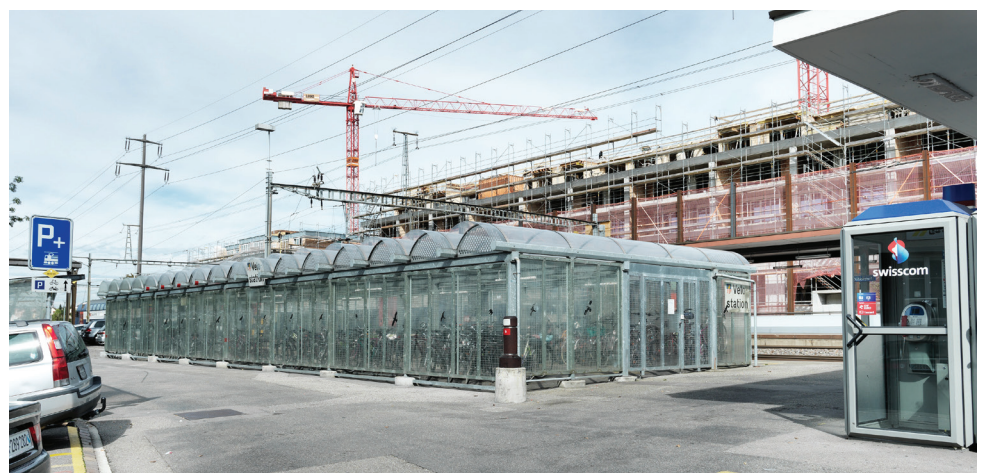
Abschliessbare Veloparkierungsanlage in Dübendorf, kostenpflichtig und mit elektronischem Zutrittssystem
